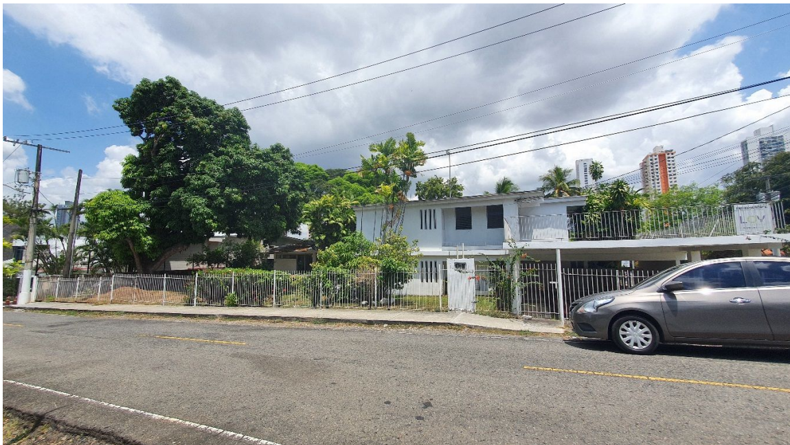
Foto N°1-2. Vistas de frente el área establecida para el futuro proyecto. Actualmente se mantienen las estructuras de una residencia en la misma.
