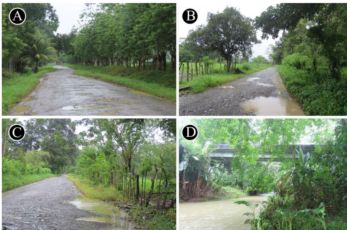
Figura 1. Área de estudio. El área del proyecto: A-B-C-D); Tramo de San San, A); Carretera hacia San San La Tigra, B); Área de cercas vivas en la vía de San San Druy-La Tigra, C); Puente sobre el Río San San, D). Diseño y Construcción de Calle San San – San San La Tigra - San San Druy – Alto Sorón, Bocas del Toro, Panamá, 2021.
