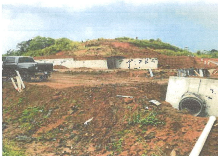
FIGURA 2. Parte del sistema de drenaje de las aguas pluviales donde se pretende desviar el flujo de agua para evitar impactos por la escorrentía. Alcantarilla a la derecha.
