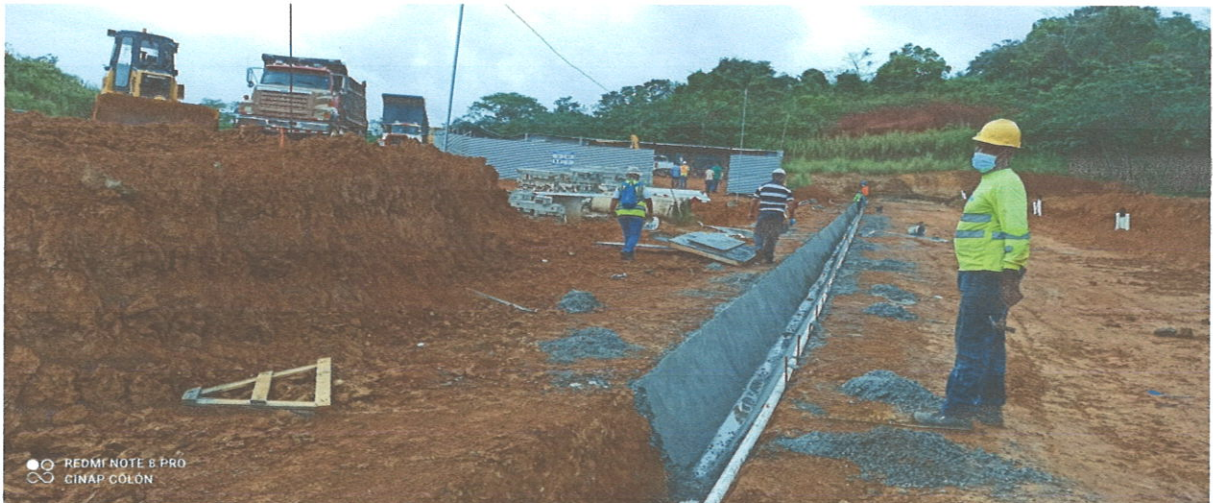
Fotografía N°4 Canales que conducirán las aguas pluviales hacia la planta de tratamiento de agua residual (PTAR).
