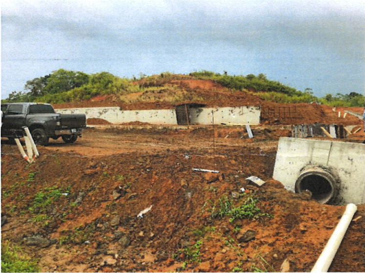
FIGURA 2. Parte del sistema de drenaje de las aguas pluviales donde se pretende desviar el flujo de agua para evitar impactos por la escorrentía. Alcantarilla a la derecha.
