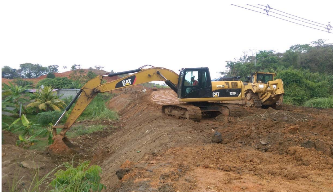
Foto 22. Dique de control de impacto de agua y conformación del drenaje de la misma
