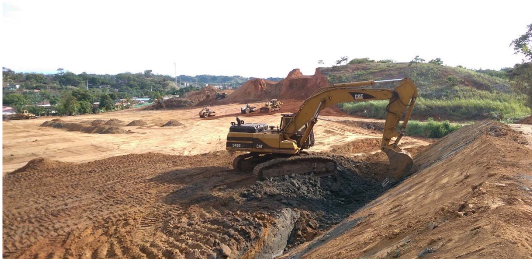
Foto 19. Medida de mitigación generando conformación de taludes y canal para las aguas pluviales (escorrentia)
