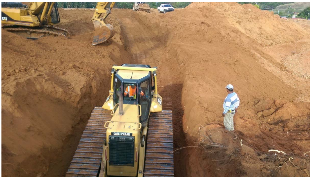
Foto 20. Barrera subterránea con material debidamente compactado que garanticen la estabilidad de los rellenos
