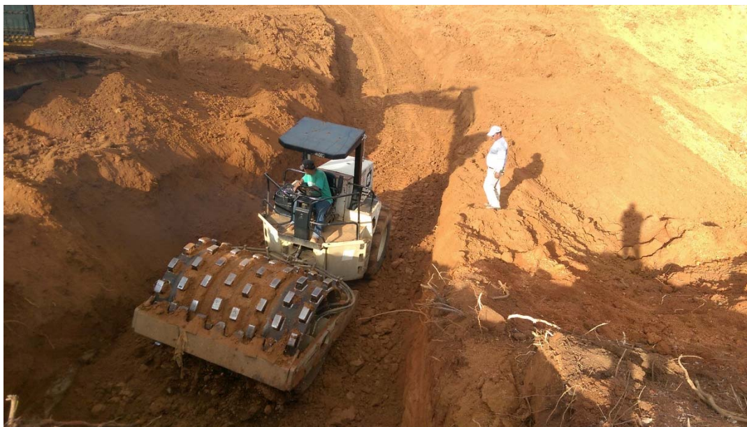
Foto 21. Barrera subterránea con material debidamente compactado que garantizan la estabilidad de los rellenos
