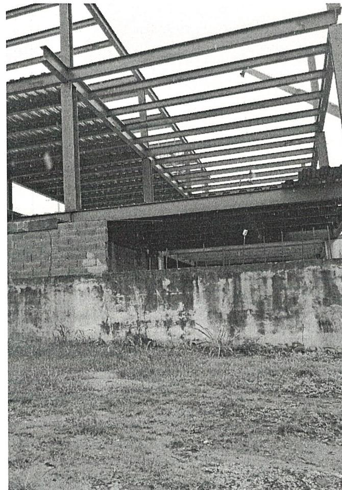
**Imagen 1, 2:** imágenes de la obra física, donde se observa la instalación de las viga “H”, que sirven como soporte, al momento de la inspección la obra se encontraba paralizada temporalmente, de manera voluntaria por parte del promotor, según informa el encargado de la obra, hasta tanto se obtengan todos los permisos correspondiente.
