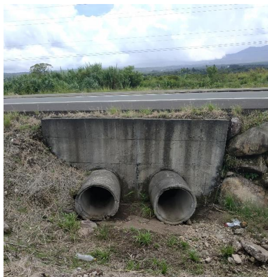
Figura 8. Alcantarilla existente (georreferenciada en las UTM 340954 E – 962368 N) que pasa por debajo de la vía Boquete Fuente: Equipo consultor, 2021.
