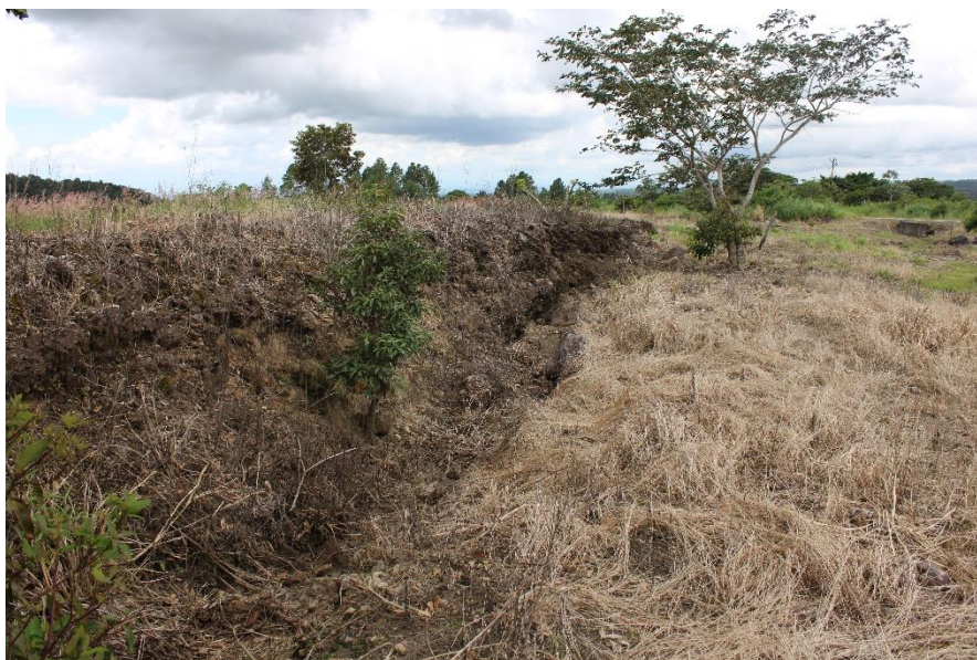
Figura 12. Zanja que recoge las aguas de escorrentía
