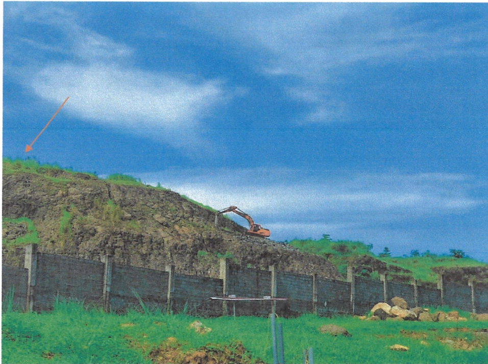
Foto 2. Se cuenta con muro perimetral que separa la zona de roca de la zona de construcción de las residencias. Esta cara se trabajará con martillo hidráulico para fragmentar la roca. La voladura se realizará en la cara trasera.
