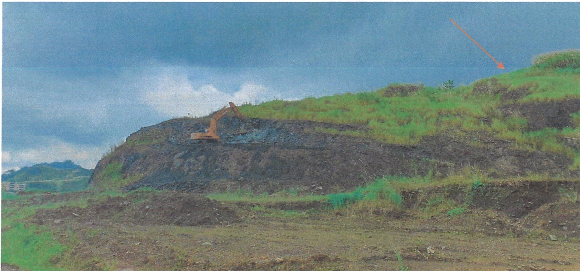
Foto 1. Actualmente se utiliza martillo hidráulico en la cara que da hacia las casas habitadas. El área a fragmentar con voladura está detrás de esta zona, de manera que sirva de barrera, tal como se explicó arriba.
