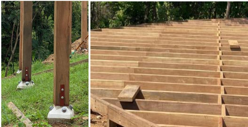
**FIGURA 6** – Ilustración de las plataformas y pilotes.
