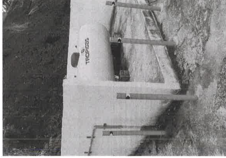
(Fig. 10) También observamos el tanque de gas colocado; sin embargo, la licenciada nos menciona que no está suministrado aún gas, la válvula se encuentra cerrada.
