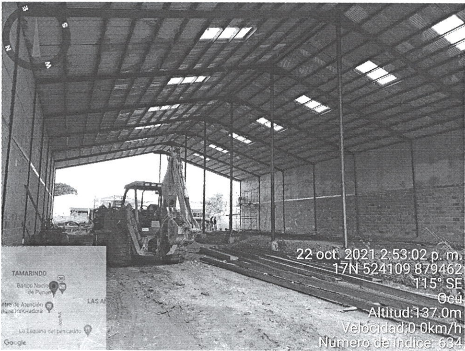
Fig. No. 3: Remodelación de una galera existente, bloqueo de paredes laterales de la misma.
