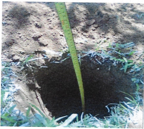
EXCAVACION DE 60CM DE PROFUNDIDAD POR 30CM DE DIAMETRO
