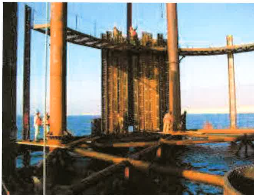
FOTO. Instalación de tablaestacas de ataguía en arco plantilla
