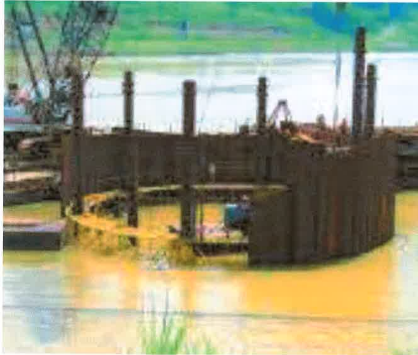
FOTO INSTALACION DE TABLAESTACAS EN PLANTILLA
