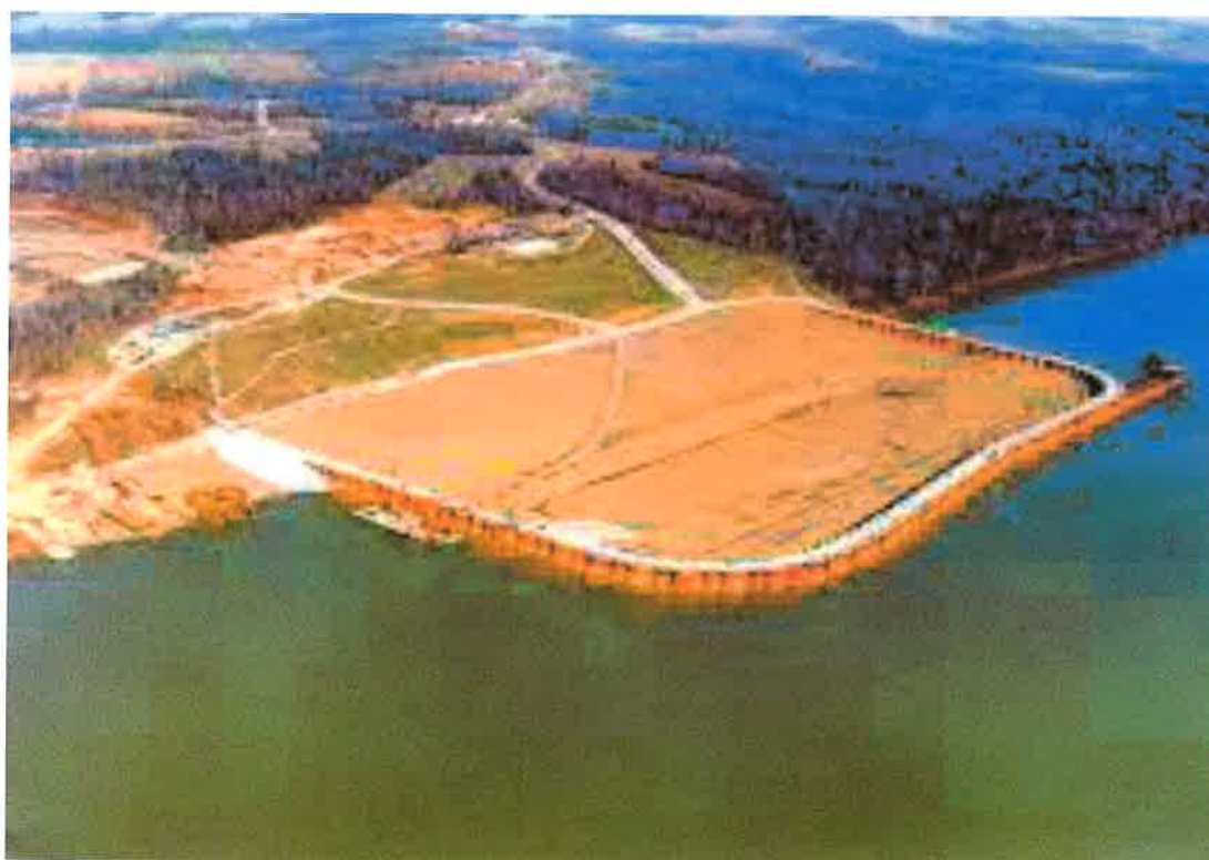
FOTO A09 PATIO DE CONTENEDORES RELLENO
