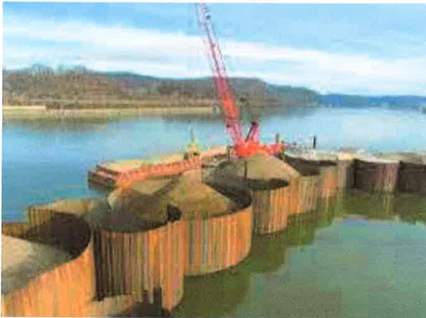
FOTO RELLENO DE CELDAS (ATAGUIAS)
