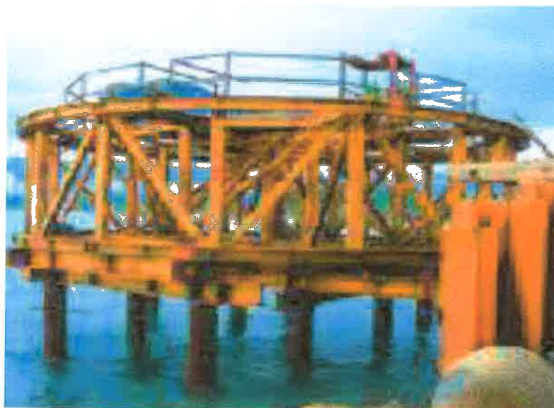
FOTO. Arco plantilla armado para recibir tablaestacas
