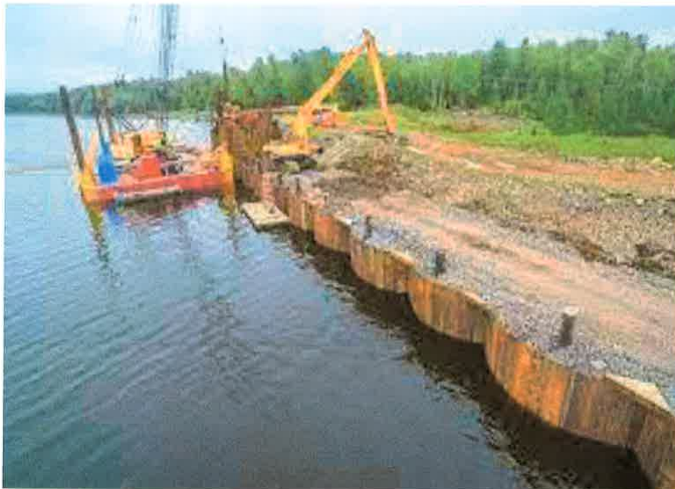
FOTO. Instalación de arcos de plantillas
