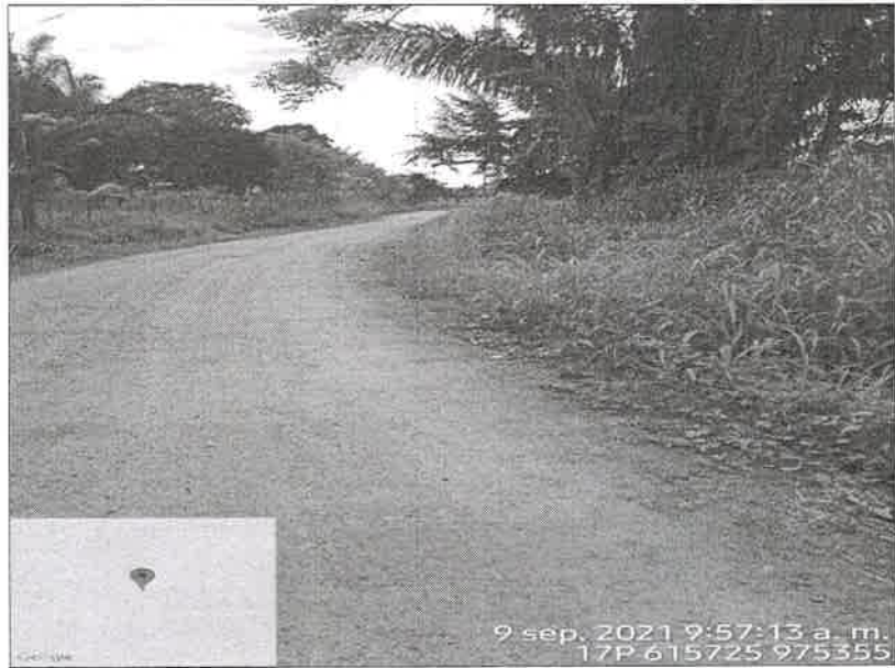
Imagen 5 y 6: Carretera a rehabilitar, conformada de tosca y tierra. Se observa la vegetación en la servidumbre de la misma compuesta de gramíneas y árboles aislados, que de ser necesario, serán intervenidos.
