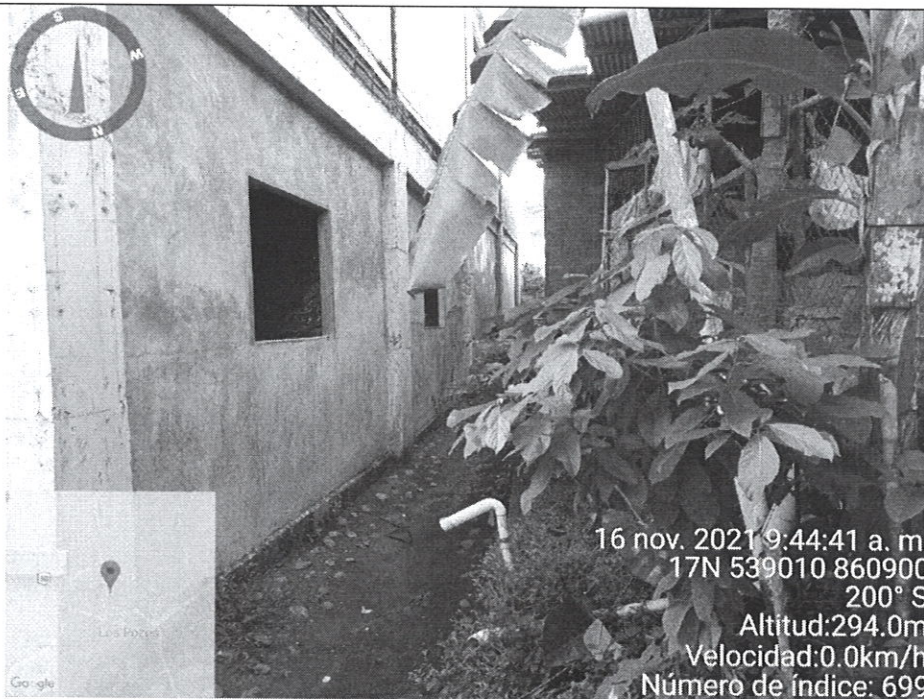
Fig. No. 8: Canalización de escorrentía pluvial a un costado de la edificación, también en esta canalización se vierten aguas domésticas de las residencias colindantes.
