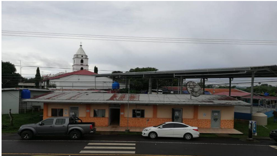
Foto N°6 Vía Las Minas
