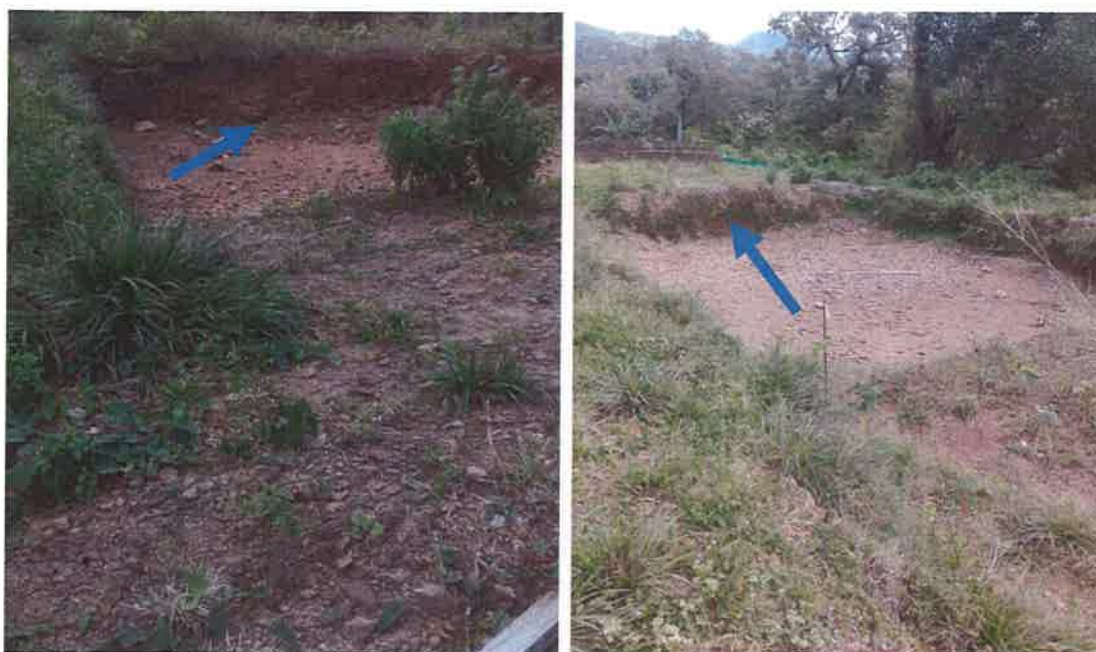
Fotos 2 y 3. Excavaciones viejas donde se observa la profundidad del relleno depositado de aproximadamente un metro.
