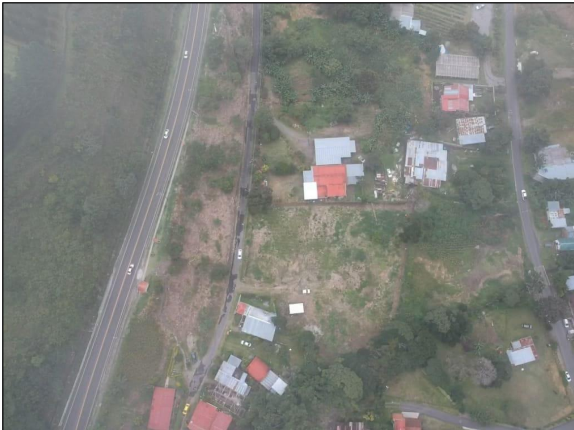
Se observa las calles paralelas al sitio del proyecto, donde a la izquierda es la vía principal de ingreso al pueblo de Boquete y la segunda importante es la avenida Belisario Porras.
