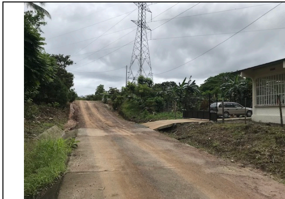
Foto No. 1 : Tramo inicial
