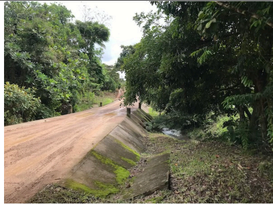
Foto No. 2 : Tramo inicial
