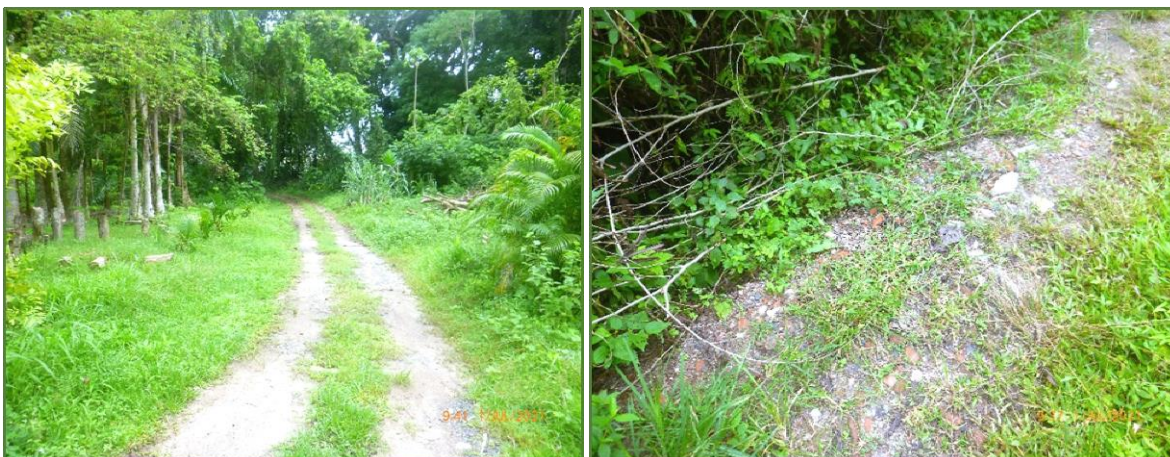
Foto 2 y 3. Vista del camino de tosca y grava compactado en medio del proyecto.
