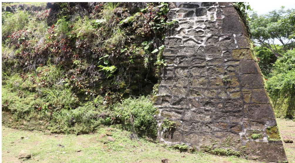
Ilustración 13 Muro del Hornabeque discontinuidad del paramento
