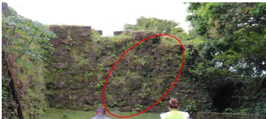
Ilustración 3. Grieta en el Muro Trávés
