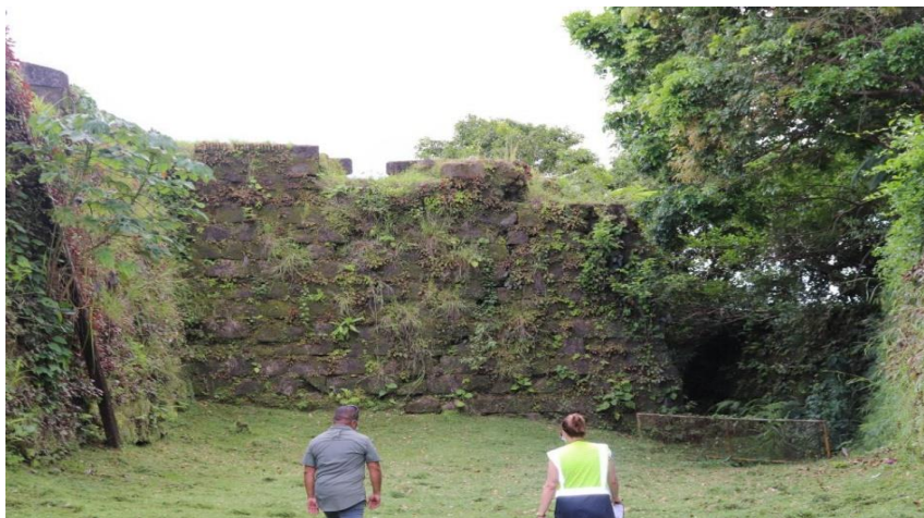
Ilustración 15 Muro Través Falla de Cuña
