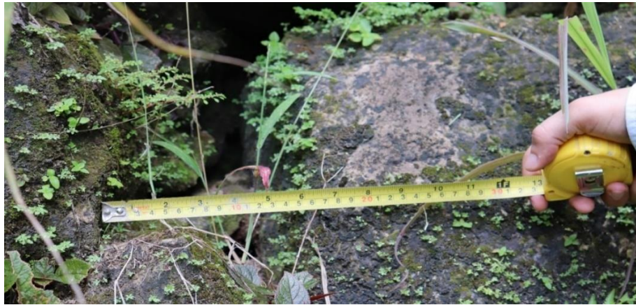
Ilustración 4. Detalle de la grieta en el Muro Través
