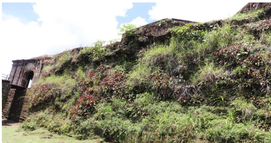
Ilustración 12 Muro de Hornabeque presencia de grietas y crecimiento vegetal
