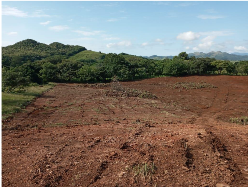
Ilustración 9. Área del proyecto nivelada y conformada
