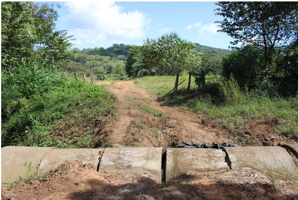
Figura 1. Estado actual de las alcantarillas sobre la Quebrada Brazo de Gómez y lugar donde se construirá el vado temporal Fuente: Equipo consultor
