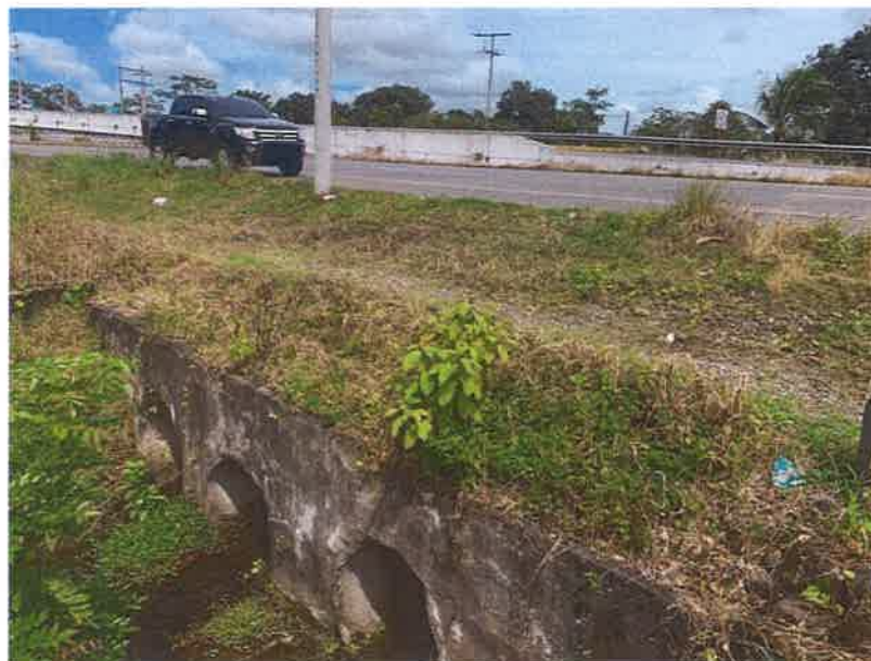
Tuberías de 60 cm existentes a alargar
