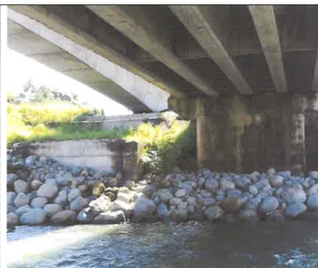
Foto 5. Vista de la base del puente a demoler y las piedras acumuladas para protección.
