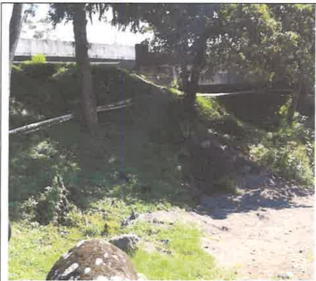
Foto 3. Vista de las tuberías de agua potable que están suspendidas en el costado del puente a demoler.
