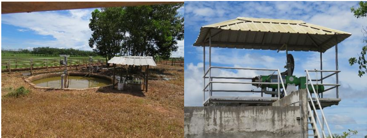
Figuras 10 – 11. Separador de sólidos, sistema de bombeo de agua y sólidos. (Imagen ilustrativa suministrada por el promotor).
