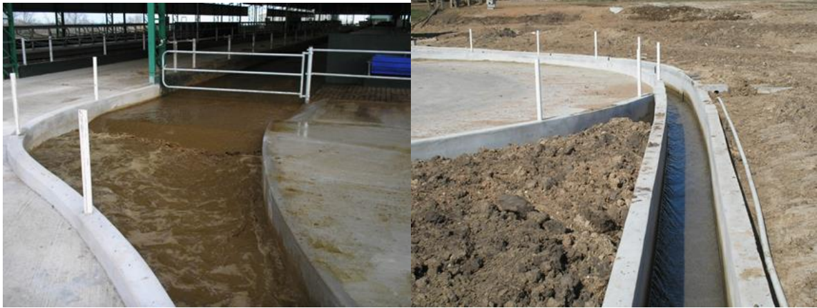
Figura 8 - 9. Canal de transporte hacia lagunas de manejo (imagen ilustrativa suministrada por el promotor).
