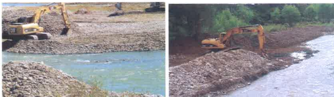
Ejemplo de ubicación de los equipos de extracción de material en el río.
