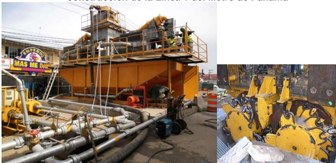
Figura N°5-8: Vista a modo de ejemplo de hidrofresadora utilizada durante la construcción de la Línea 1 del Metro de Panamá
