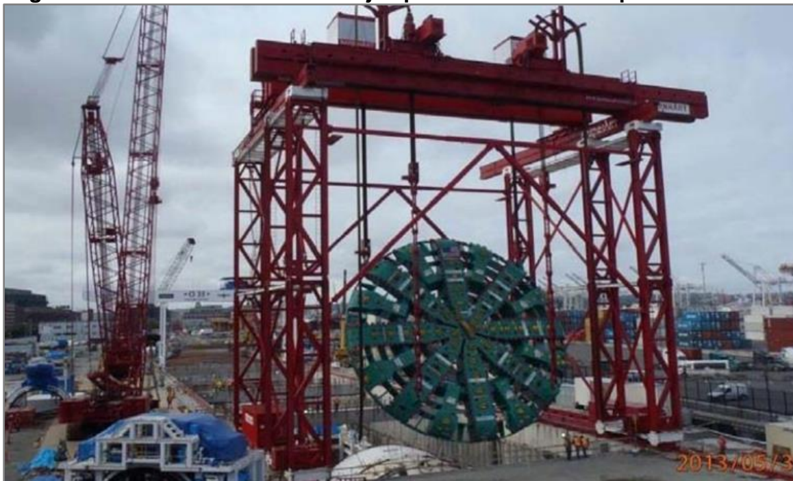
Figura N°5-5: Vista a modo de ejemplo del izamiento de partes de la TBM
