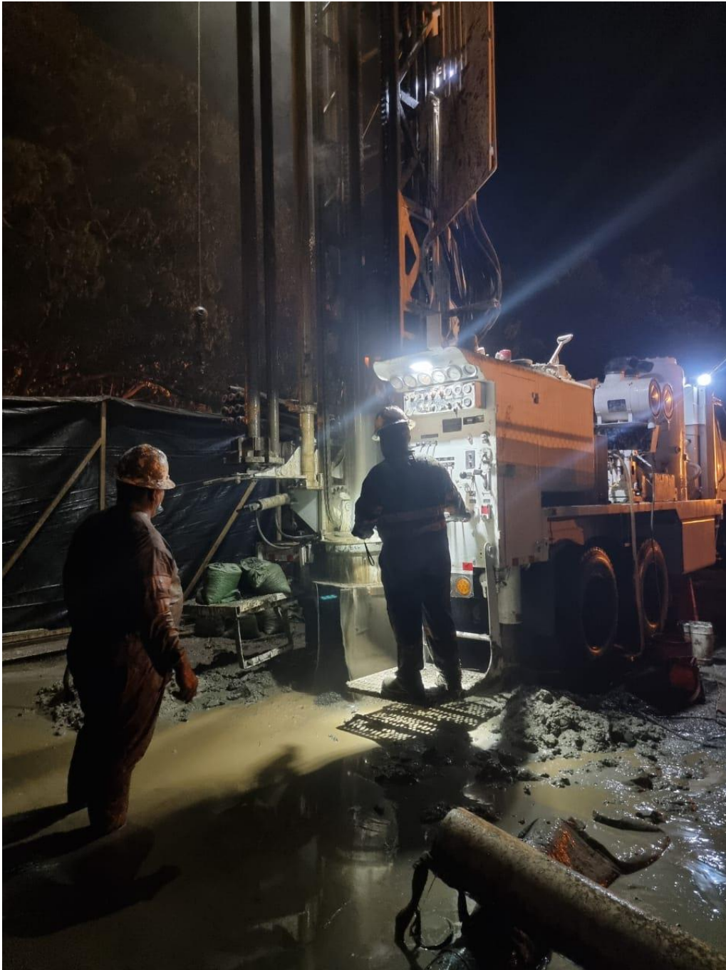
PERFORACION DE POZO EM-11
