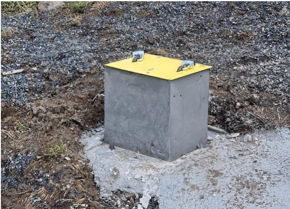
CONSTRUCCIÓN DE SELLO SANITARIO Y MONOLITO CON TAPA
