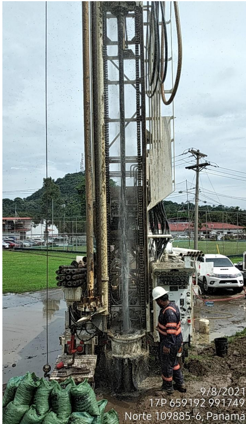
PERFORACION DE POZO EM-14
