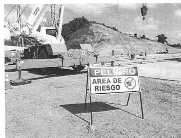
Imagen 7: grúa para levantamiento y colocación de vigas H.
