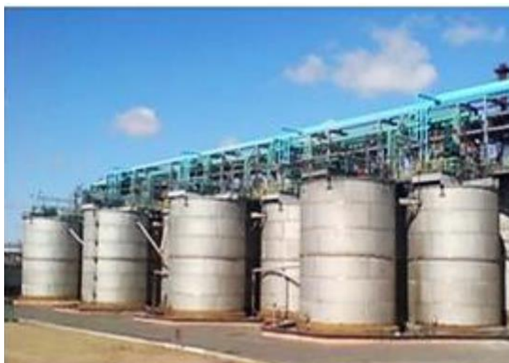
Figura 5.27. Tanques de cianuración.
