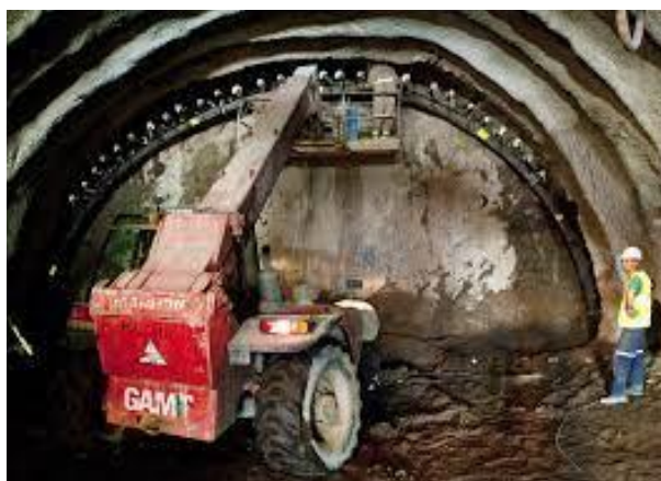
Foto 5.3. Sostenimiento con hormigón
