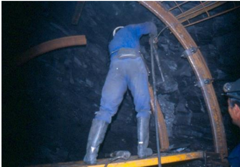
Foto 5.5. Colocación de cuadros metálicos.
