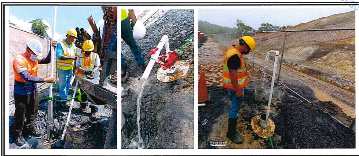
Fig.21, 22 y 23- Proceso de instalación del equipo de bombeo y proceso de bombeo a 15 gpm, en el pozo exploratorio PPA.
