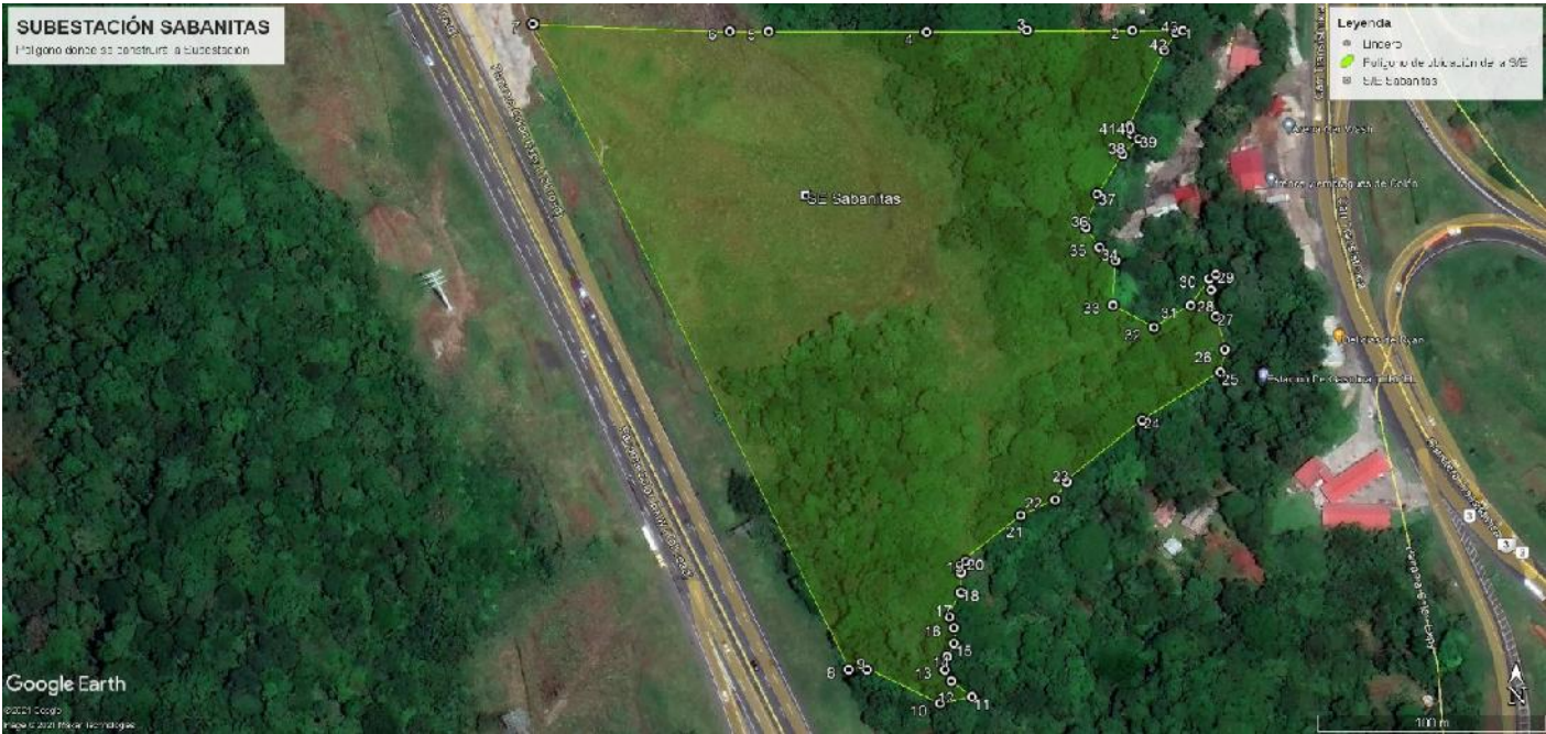
Figura 5.2. Imagen de satélite con coordenadas del lote donde se construirá la Subestación Sabanitas
