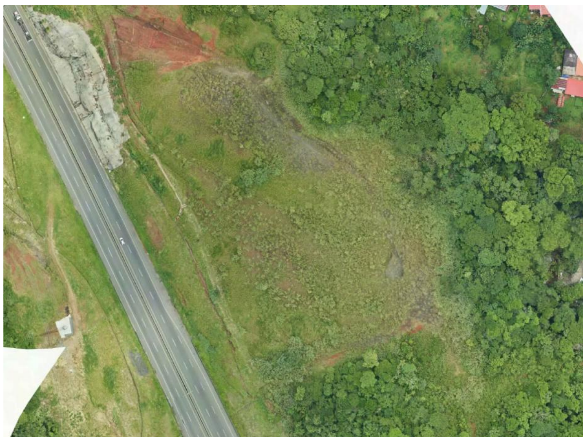
Figura 8.4. Ortofoto del lote donde se construirá la Subestación Eléctrica Sabanitas 230 kV.
