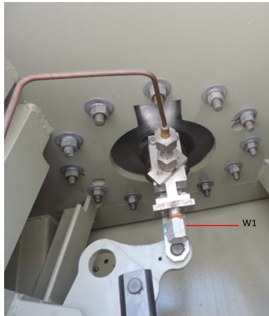
Fig.02 W1: conexión de carga CB Crompton Greaves (CG)
