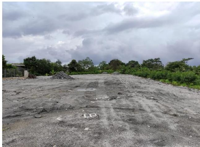
adecuación, compactación y sellado del terreno para lograr mantener el nivel actual de la terracería, el cual está un poco más alto que el de la calle. Cabe destacar que el terreno se mantendrá solo con sello y solo llevará concreto el área de construcción cerrada (galera, oficinas, acera y baños)
