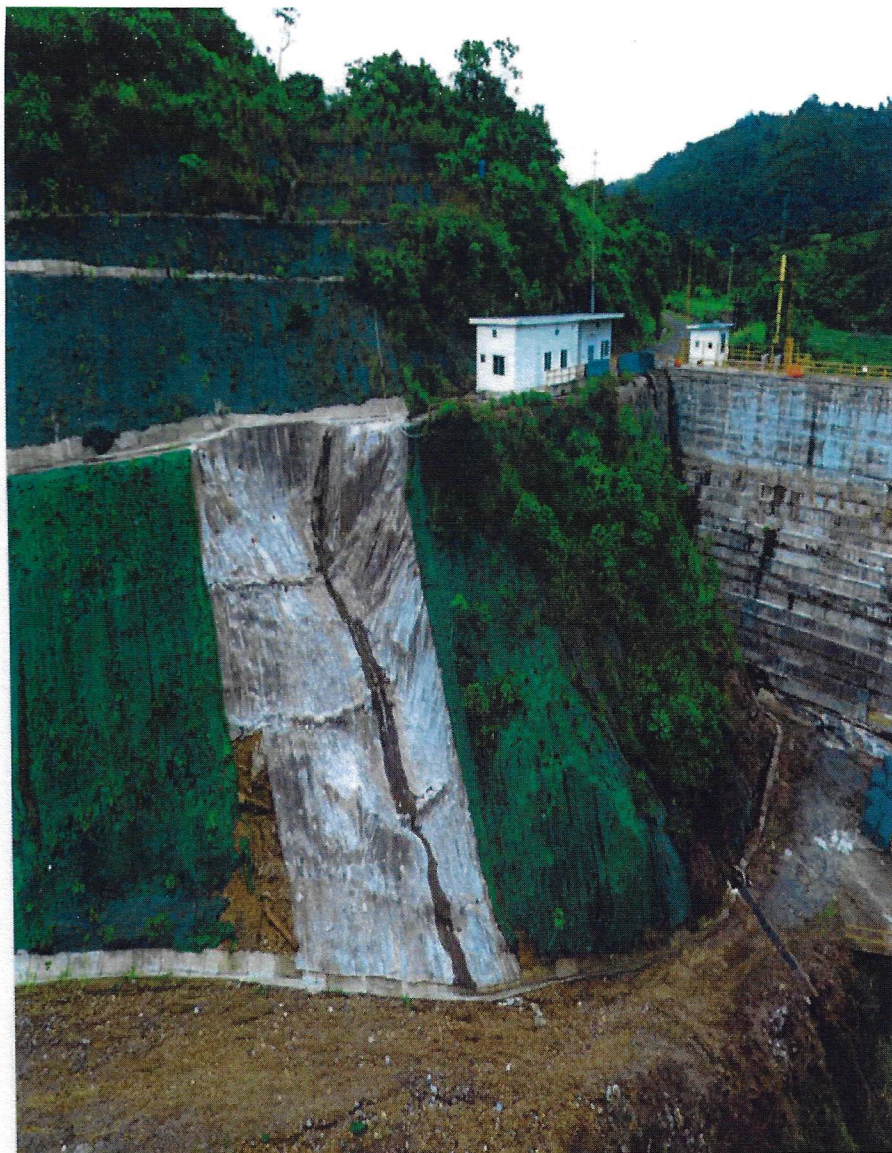
Figura 16 – Concrete canvas (foto del fabricante)
