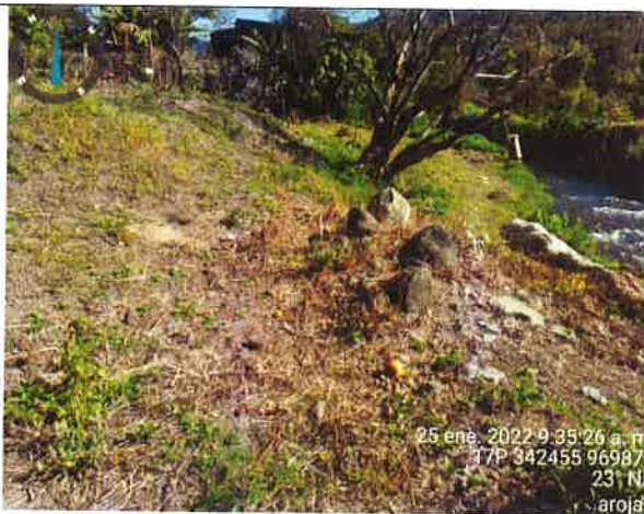
Foto 4. Vista de área con desnivel cercana a la fuente de agua.
