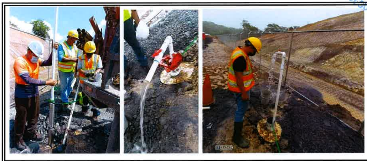
Fig.21, 22 y 23- Proceso de instalación del equipo de bombeo y proceso de bombeo a 15 gpm, en el pozo exploratorio PPA.
