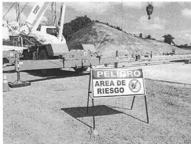
Imagen 7: grúa para levantamiento y colocación de vigas H.
