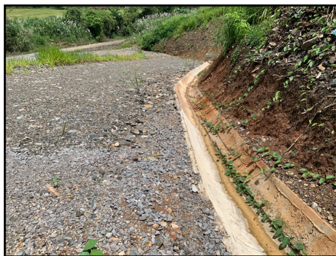
Fotografías No. 5-1, 5-2 y 5-3: Vía de acceso interno y cunetas existentes, Fuente: Ing. Seabell Pastor, Septiembre 2021
