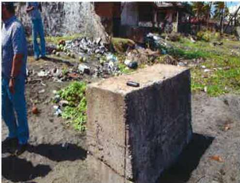
Sitio de Anclaje (Estructura de Hormigón), condicionada para recibir el cable Submarino.
