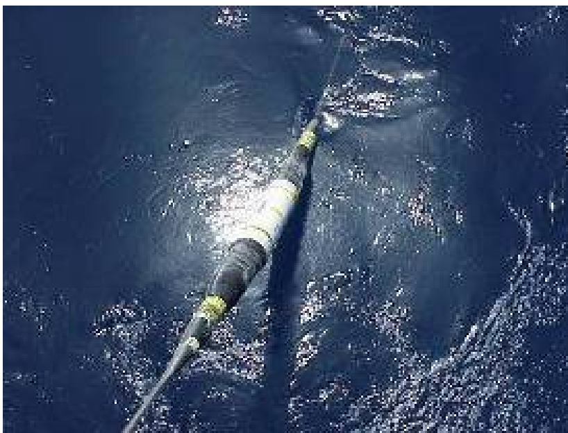
Figura 5-5: Colocación de un repetidor
