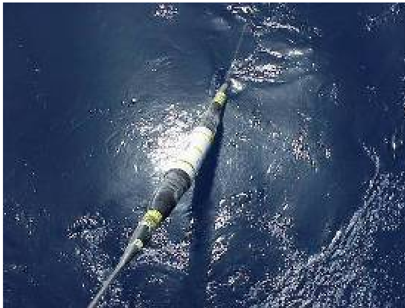
Figura 2.2-5: Colocación de un repetidor
