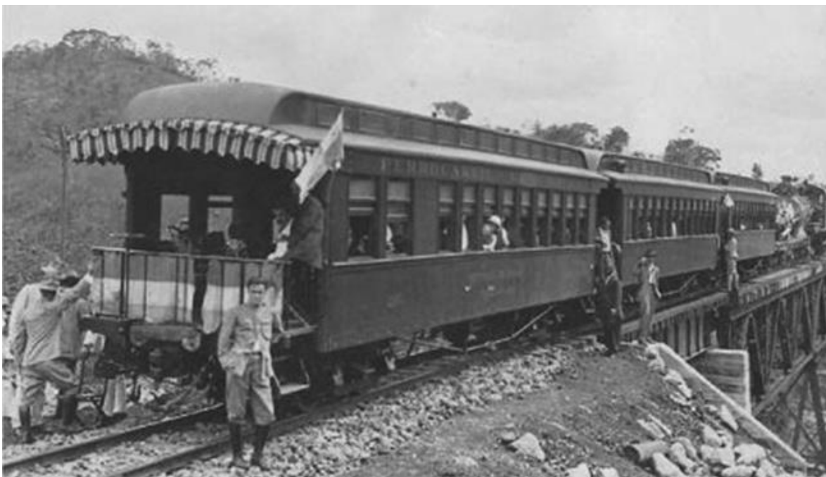
Fig. 30. Fotografía de un tren del Ferrocarril Nacional de Chiriquí. Nótese la capa de piedra (balasto) debajo de los rieles de tren, este relleno posiblemente corresponda al estrato identificado en los pozos de sondeo efectuados sobre la plataforma. Fuente: Panamá Vieja Escuela.
