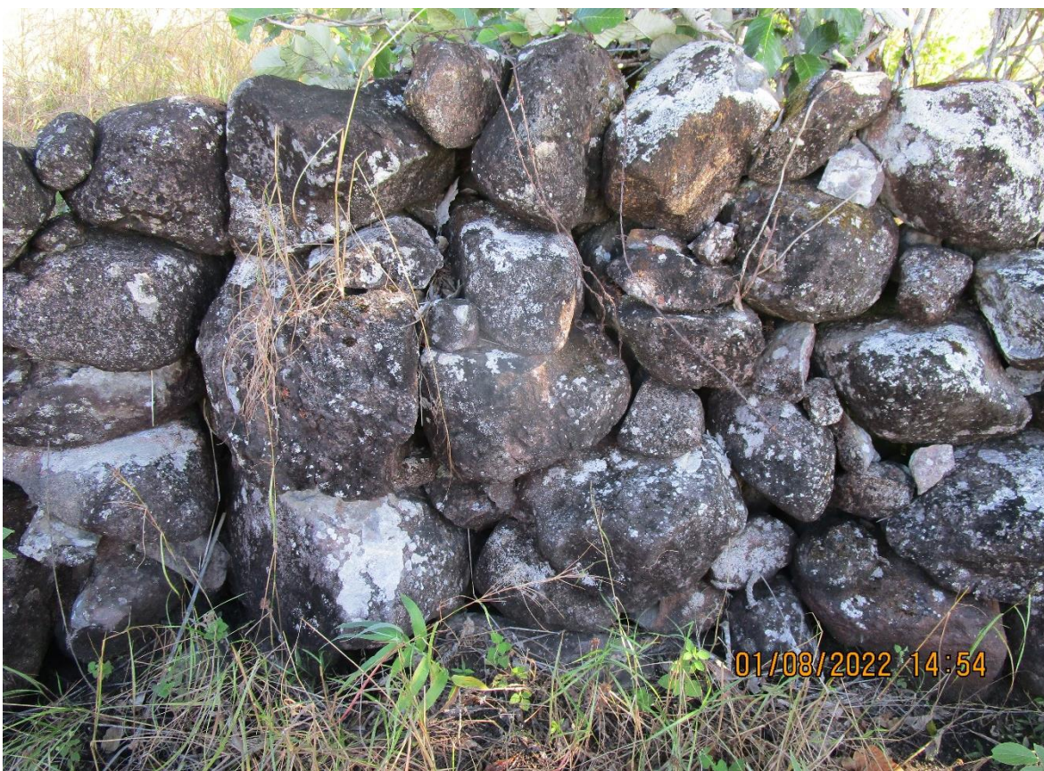
Fig. 9. Detalle de la cerca de piedras perimetral. Nótese la ausencia de mortero.
