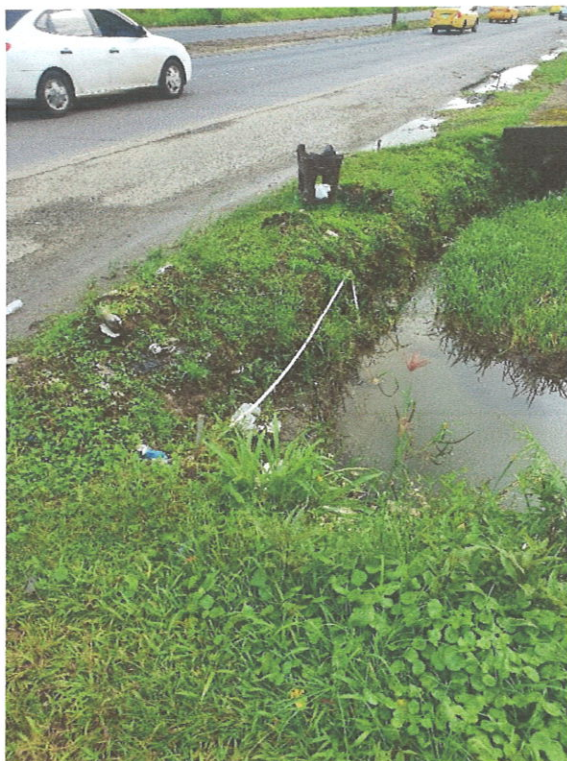
Foto No. 4.0-1 Tubería que lleva agua a la residencia de la Sra. Linixa.
