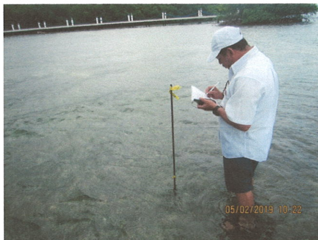
Foto 3: Georreferenciación del punto numero dos donde se anclarán los pilotes para la obra.
