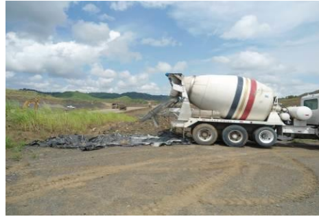
Foto N° 5-2 Lavado de camiones concreteros
