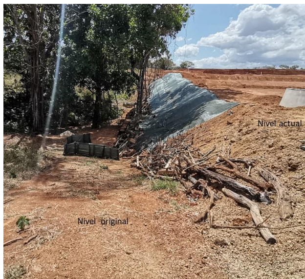
Foto 5. Vista de perfil de la terracería a un costado del lote y actividades de control de erosión. Fuente: Datos de campo
