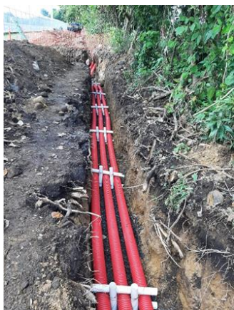
Imagen #1 zanja de ductos para cables
