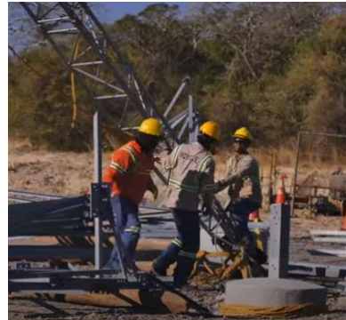
Imagen #8 y 9 Imagen de referencia de armado de torres de transmisión
