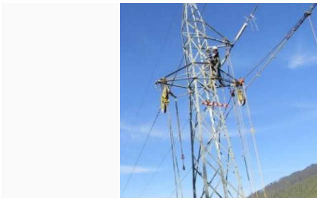
Imagen #11 Instalación de conductores en torres de transmisión
