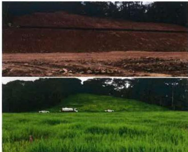
La dosificación del mulch es de acuerdo con el proveedor y a las condiciones de cada talud por lo que varía según su inclinación. La dosificación de la semilla es según el proveedor.
