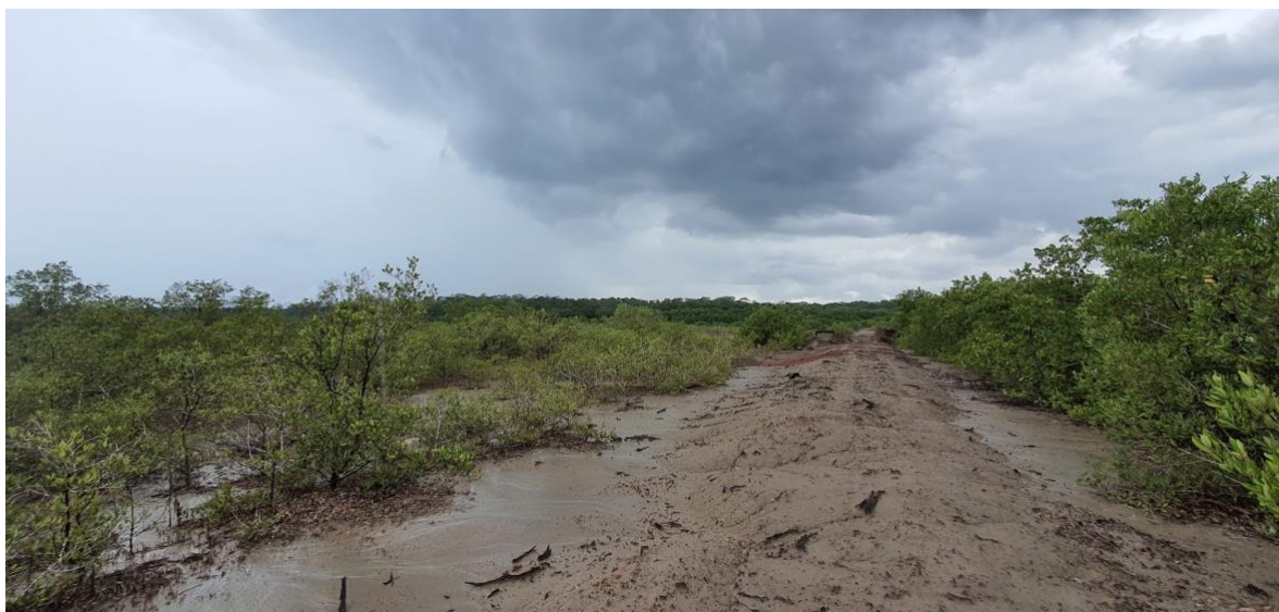
Fig. 8.- Camino erosionado entre estanques con recremento de vegetación.
