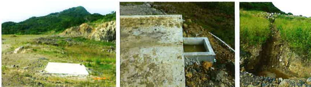
Plataforma de concreto con trampa de aceites y gradas y tina de decantación de sedimentos, para el lavado de los equipo del proyecto.
