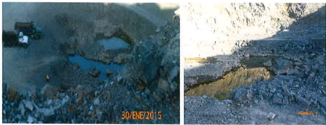
Tinas de decantación de sedimentos y filtros de rocas en los drenajes naturales de las aguas de escorrentía.
