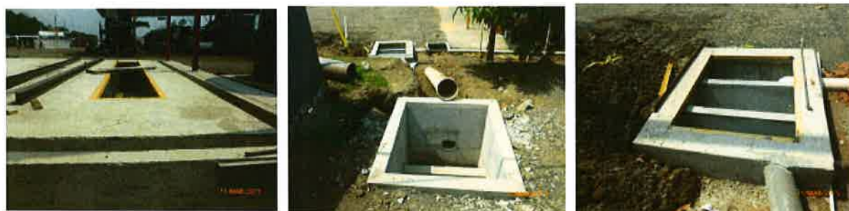
Ejemplos utilizados en minería, para el lavado de camiones y equipos: Plataforma de concreto con trampa de aceites y tinas de decantación de sedimentos, para el lavado de los equipos y mantenimiento en el proyecto.
