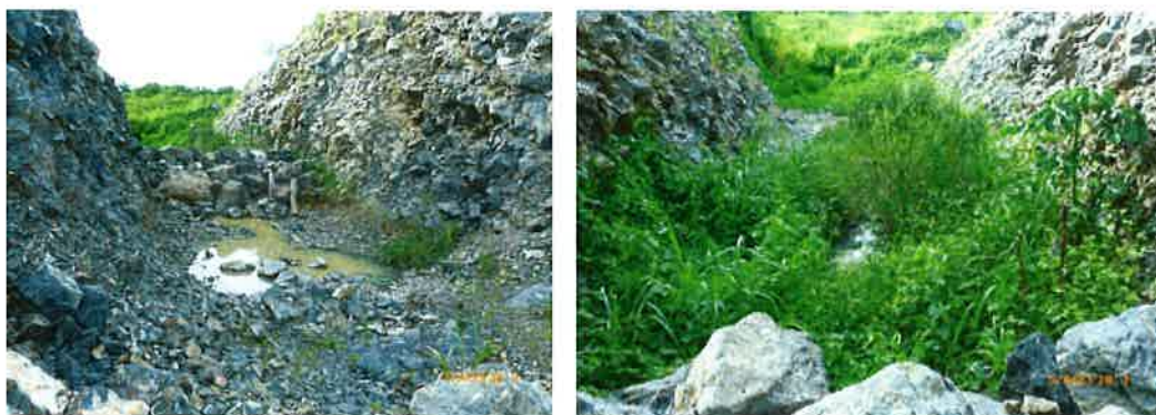
Filtro de roca y tina de decantación de sedimentos, antes de la descarga al sistema natural de drenaje.
