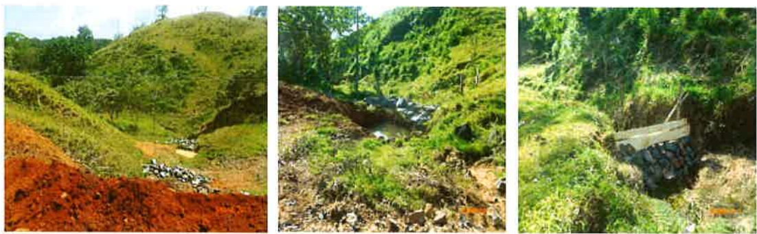
Tinas de decantación de sedimentos y filtros de rocas en los drenajes naturales de las aguas de escorrentía.
