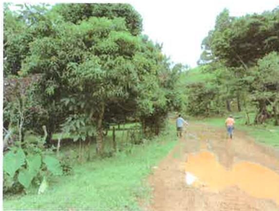
**Fotos 35, 36, 37, 38, 39** Tramos prospectados de caminos de tierra. Sin servidumbre. Terreno plano en algunos sectores y en otros, alterado por corte y ligeras pendientes. En algunos tramos se observó zonas anegadas, y cortes de terreno en tramo caminos de más de metros sobre el nivel del suelo.
