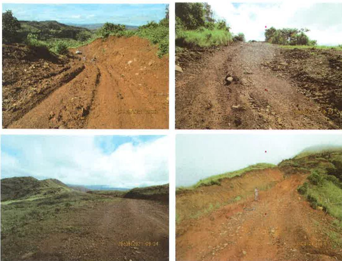
Fotos 5, 6, 7, 8, 9. Aplicación de sondeo, tramos prospectados de caminos de tierra. Sin servidumbre. Terreno plano en algunos sectores y en otros, alterado por corte y ligeras pendientes.
