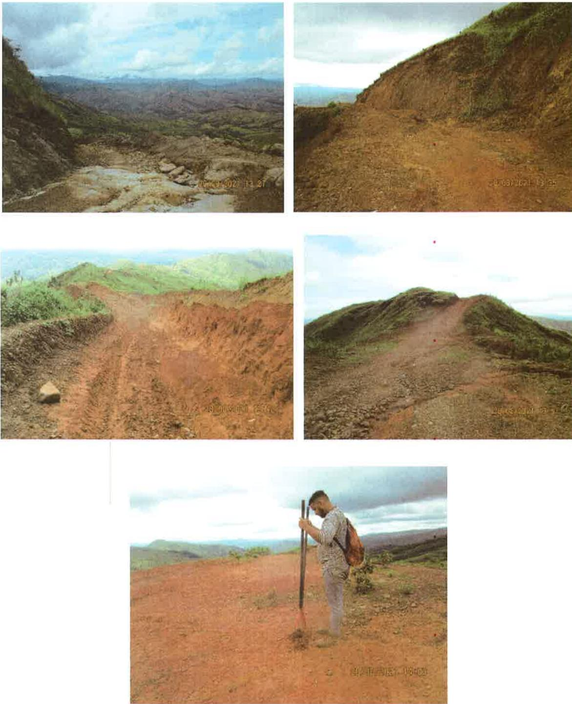
Fotos 20, 21, 22, 23 y 24 Tramos prospectados de caminos de tierra. Sin servidumbre. Terreno plano en algunos sectores y en otros, alterado por corte y ligeras pendientes. Aplicación de sondeo.
