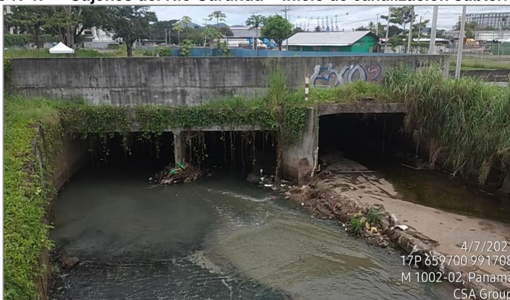
Foto N°1. Cajones del Río Curundú – Inicio de canalización subterránea
